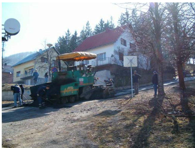
Završni radovi na izgradnji sustava fekalne odvodnje u ulici Grič
