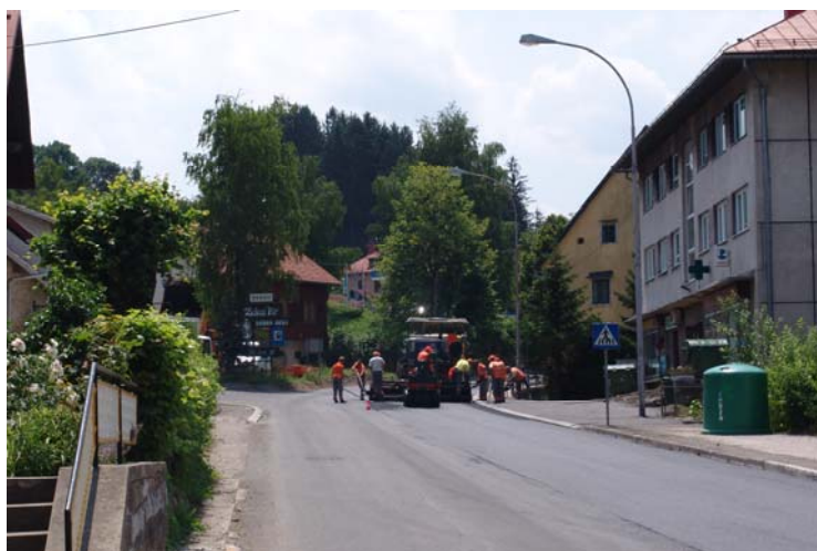
Sanacija prometnice D-3 Goranskom ulicom
