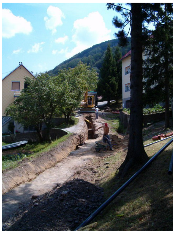
Radovi na sustavu odvodnje u ulici Grič
