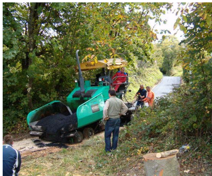
Asfaltiranje naselja Rogi
